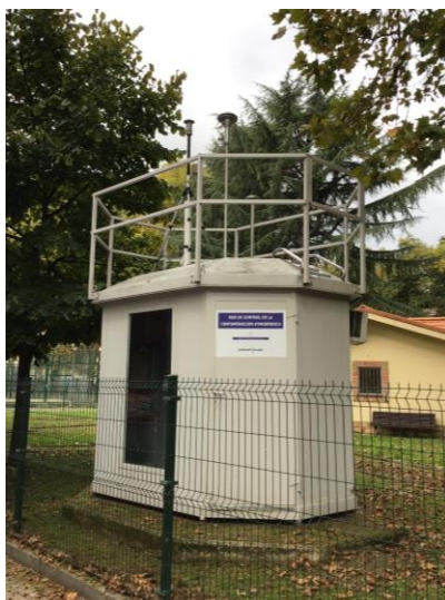
Figura 39. Estación Sama I
