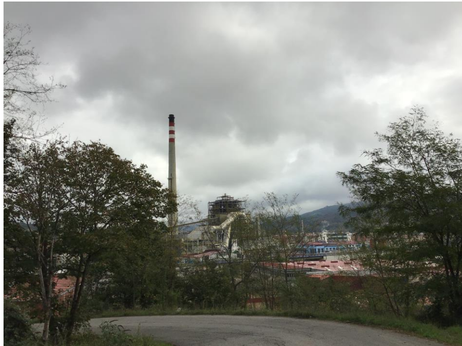
Figura 27. Chimenea de la Central Térmica de Lada
