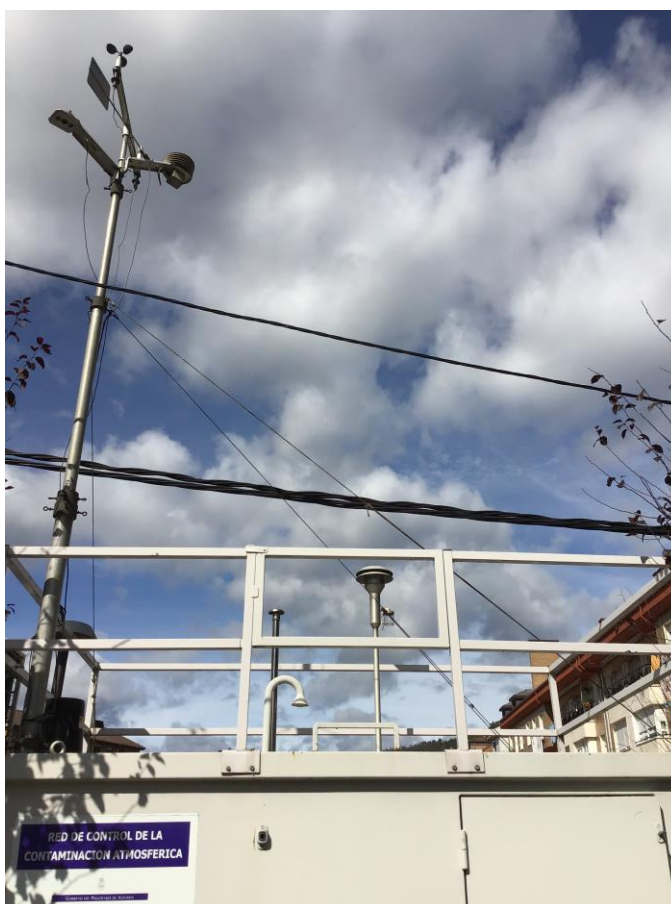
Figura 90. Toma de muestra de gases y partículas y estación meteorológica de la estación Jardines de Juan XXIII
